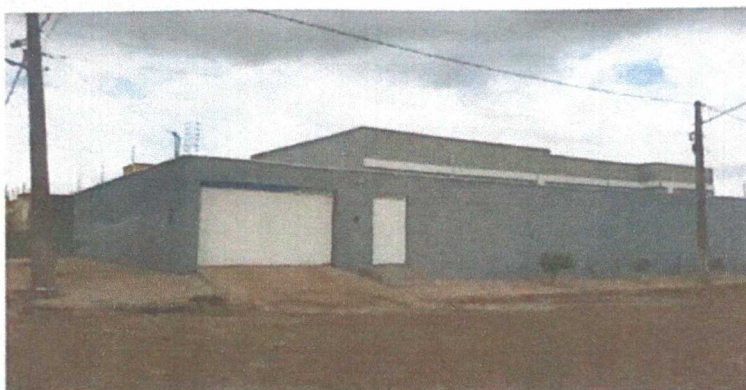
Imagem 01: Fachada Frontal da obra
