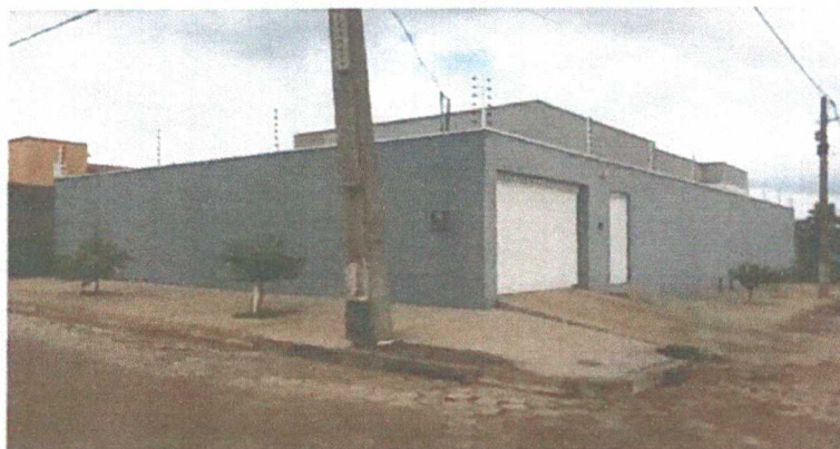
Imagem 02: Fachada Frontal e Lateral da obra
