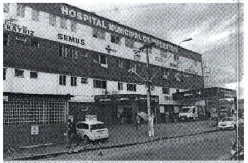
Acordo foi firmado a fim de assegurar a continuidade dos serviços de saúde nos hospitais municipais de Imperatriz
