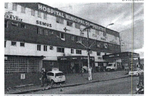
Acordo foi firmado a fim de assegurar a continuidade dos serviços de saúde nos hospitais municipais de Imperatriz
