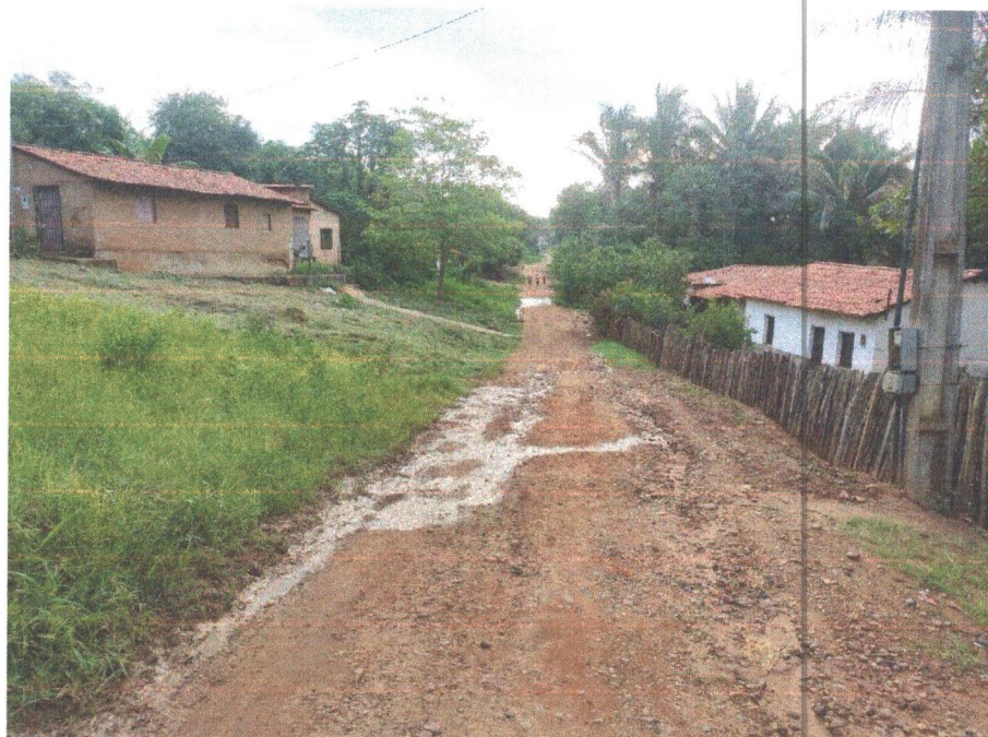
FOTO Nº 4 – RUA RIO MEARIM
