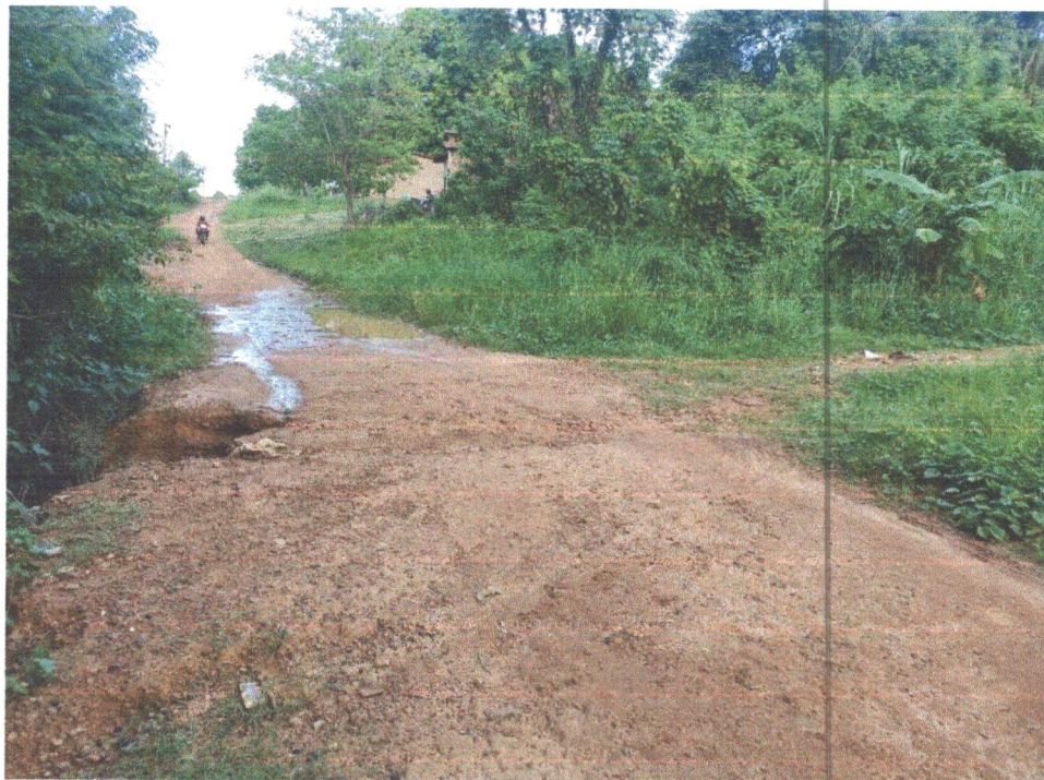
FOTO Nº 7 – RUA RIO MEARIM
